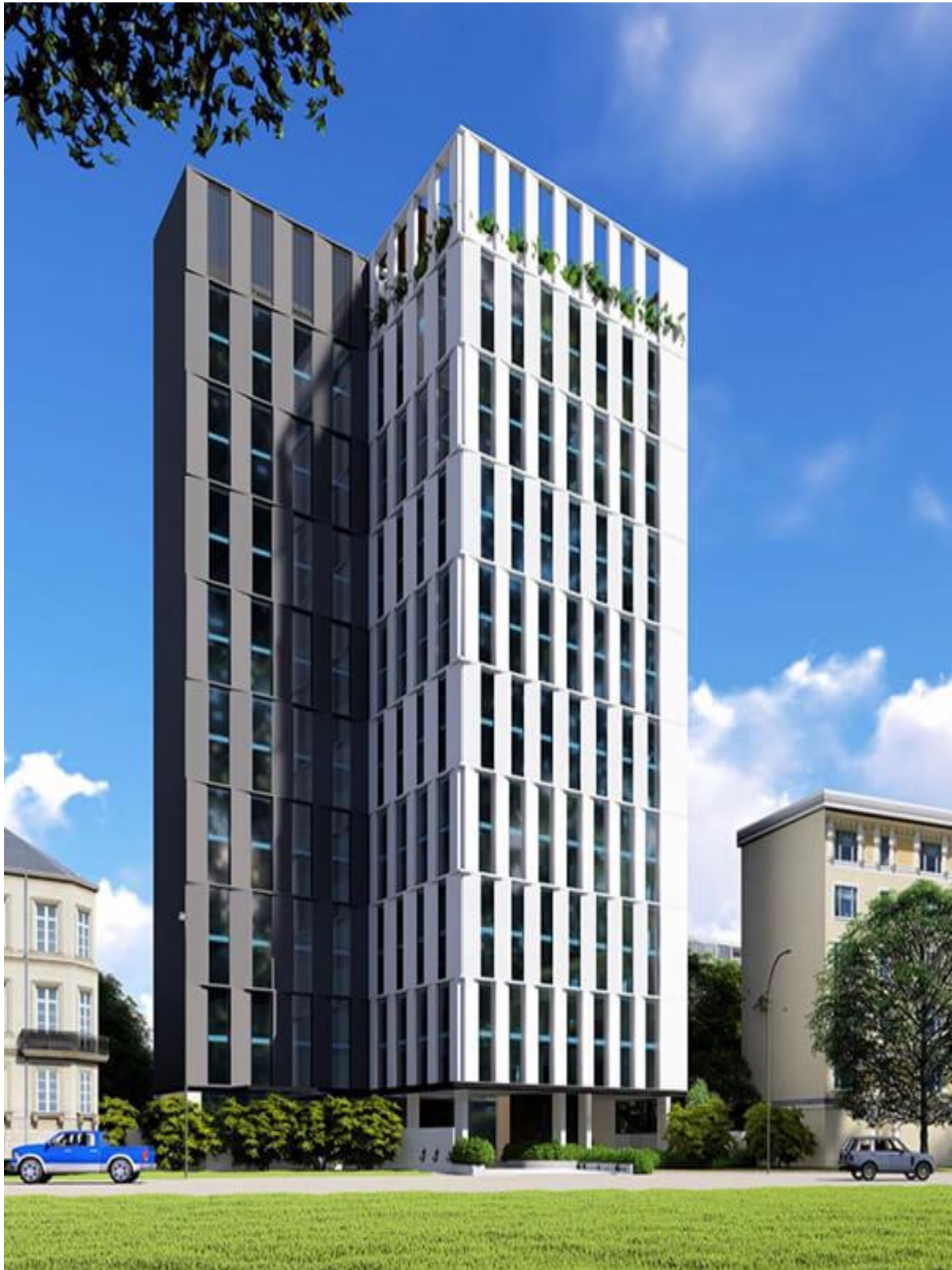
CÔNG TRÌNH/ CONSTRUCTION: KIỂM ĐỊNH ĐÁNH GIÁ CHẤT LƯỢNG HIỆN TRẠNG KẾT CẤU CÔNG TRÌNH KHÁCH SẠN SÀI GÒN GATEWAY
