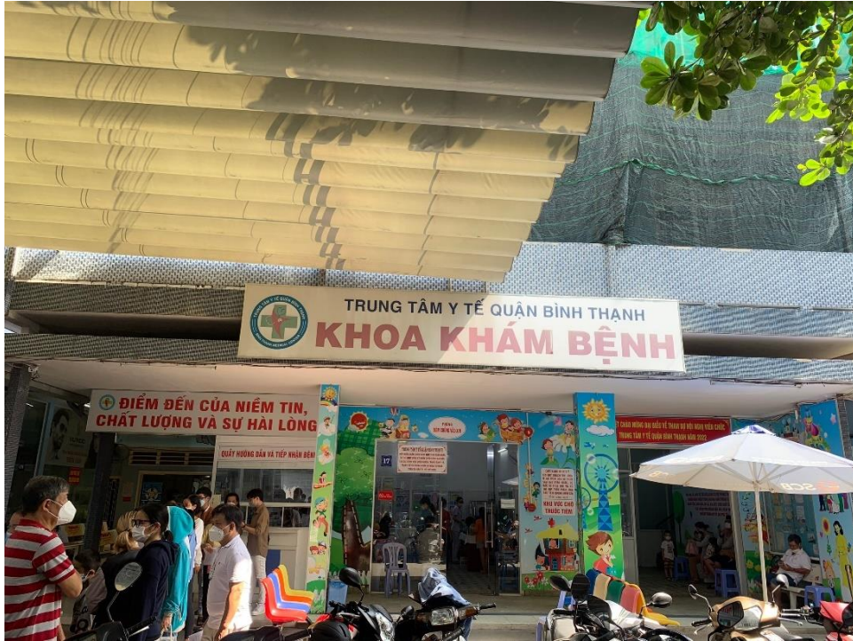
CÔNG TRÌNH/ CONSTRUCTION: KIỂM ĐỊNH HIỆN TRẠNG CHẤT LƯỢNG CÔNG TRÌNH PHỤC VỤ CÔNG TÁC CẢI TẠO SÂN THƯỢNG LẦU 2 LÀM HỘI TRƯỜNG CƠ SỞ 1 CHO CÔNG TRÌNH TRUNG TÂM Y TẾ QUẬN BÌNH THẠNH XÂY DỰNG TẠI 99/6 NƠ TRANG LONG, PHƯỜNG 11, QUẬN BÌNH THẠNH, TP HCM
