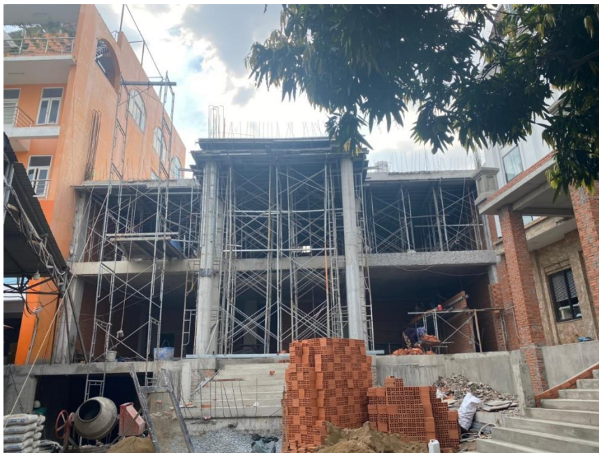
CÔNG TRÌNH/ CONSTRUCTION: KIỂM ĐỊNH CHẤT LƯỢNG SÀN TẦNG 2 CHO CÔNG TRÌNH 665A KINH DƯƠNG VƯƠNG, PHƯỜNG AN LẠC, QUẬN BÌNH TÂN, TP HCM
