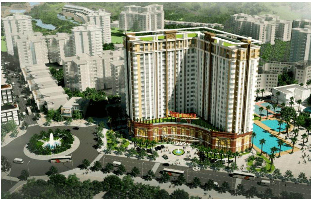
CÔNG TRÌNH/ CONSTRUCTION: THẨM TRA MÓNG CẦU THÁP, BIỆN PHÁP THI CÔNG DẦM SÀN CHO DỰ ÁN CHUNG CƯ TÔ KÝ TOWER, XÂY DỰNG TẠI 10A, Đường Tô Ký, Phường Trưng Mỹ Tây, Quận 12, TPHCM
