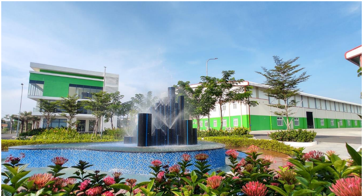
CÔNG TRÌNH/ CONSTRUCTION: GIÁM SÁT THI CÔNG XÂY DỰNG CÔNG TRÌNH NHÀ VĂN PHÒNG TẠI CÔNG TY CỔ PHẦN KHUÔN MẪU VINA LONG THÀNH, XÂY DỰNG TẠI ĐƯỜNG SỐ 1 KCN LONG THÀNH, XÃ TAM AN, HUYỆN LONG THÀNH, TỈNH ĐỒNG NAI
