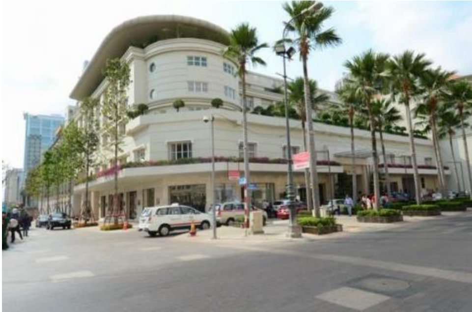
CÔNG TRÌNH/ CONSTRUCTION: KIỂM ĐỊNH KIỂM ĐỊNH ĐÁNH GIÁ CHẤT LƯỢNG VÀ KHẢ NĂNG CHỊU LỰC CỦA KẾT CẤU HIỆN TRẠNG CÔNG TRÌNH ĐỂ CẢI TẠO CHÍNH TRANG CHO KHÁCH SẠN REX SÀI GÒN
