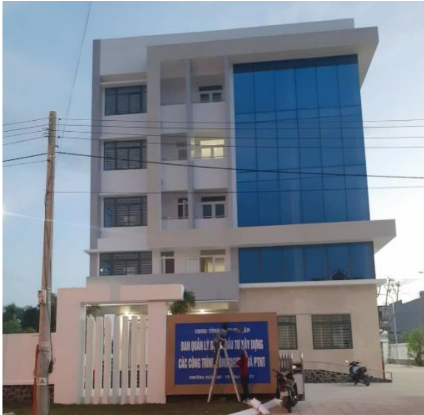
CÔNG TRÌNH/ CONSTRUCTION: KIỂM ĐỊNH CHẤT LƯỢNG CÔNG TRÌNH PHỤC VỤ LẮP ĐẶT TẤM PIN NĂNG LƯỢNG MẶT TRỜI TẠI KDC BẮC XUÂN AN, TP PHAN THIẾT, TỈNH BÌNH THUẬN
