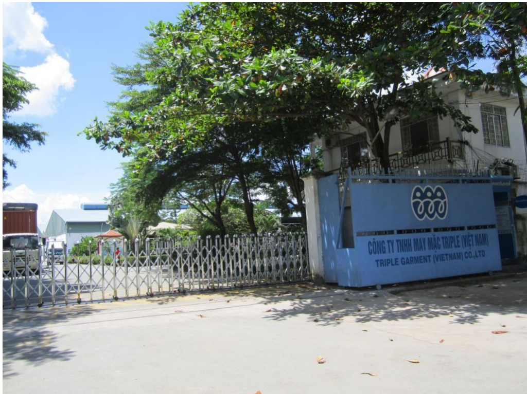
CÔNG TRÌNH/ CONSTRUCTION: KIỂM ĐỊNH HỆ KẾT CẤU THÉP SÀN LỬNG CHO CÔNG TY TNHH MAY MẶC TRIPLE VIỆT NAM
