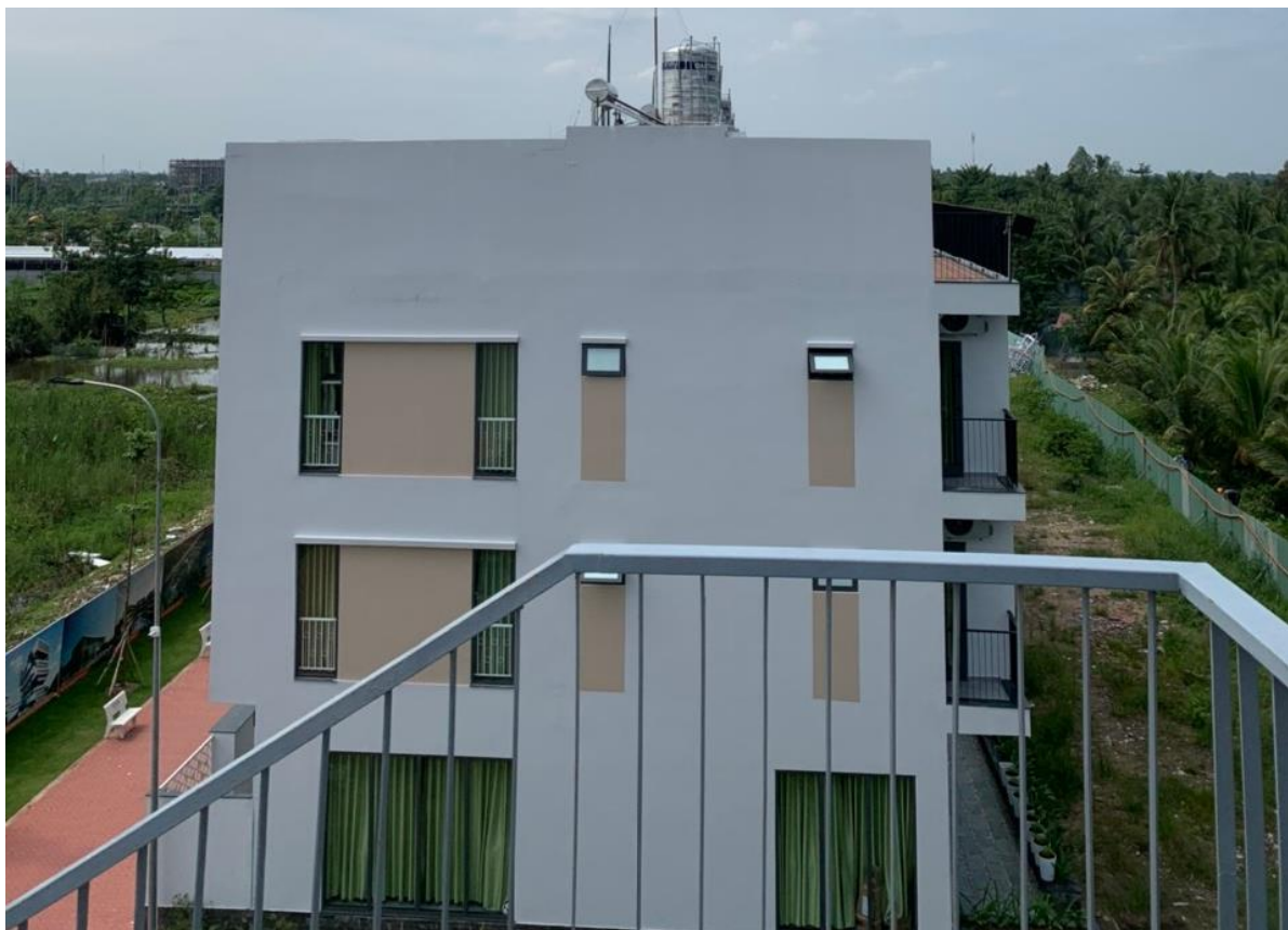
CÔNG TRÌNH/ CONSTRUCTION: QUAN TRẮC VẾT NỨT VÀ ĐÁNH GIÁ TÁC ĐỘNG HỆ KẾT CẤU SÀN SÂN THƯỢNG CHO KHU KÝ TÚC XÁ KIỂM ĐỊNH HỆ KẾT CẤU SÀN LỬNG CHO TRƯỜNG ĐẠI HỌC FPT CẦN THƠ
