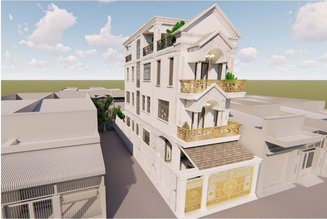
CÔNG TRÌNH/ CONSTRUCTION: THIẾT KẾ XÂY DỰNG CÔNG TRÌNH NHÀ Ở CHỦ NGHĨA, XÂY DỰNG TẠI 367/18/6 NGUYỄN THÁI SƠN, PHƯỜNG 5, QUẬN GÒ VẤP, TP.HCM
