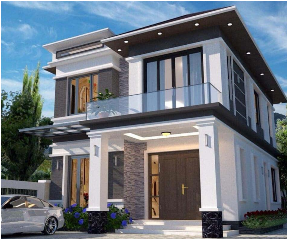
CÔNG TRÌNH/ CONSTRUCTION: THIẾT KẾ NHÀ Ở - HOÀNG ANH KHÔI, XÂY DỰNG TẠI 156/5 TỈNH LỘ 10, QUẬN BÌNH TÂN, THÀNH PHỐ HỒ CHÍ MINH
