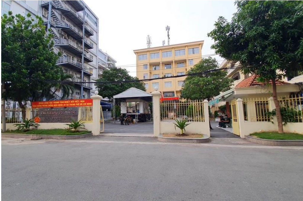
CÔNG TRÌNH/ CONSTRUCTION: KIỂM ĐỊNH HIỆN TRẠNG CHẤT LƯỢNG CÔNG TRÌNH CHO CẢI TẠO, MỞ RỘNG NHÀ LÀM VIỆC S1 - CHI NHÁNH PHÍA NAM
