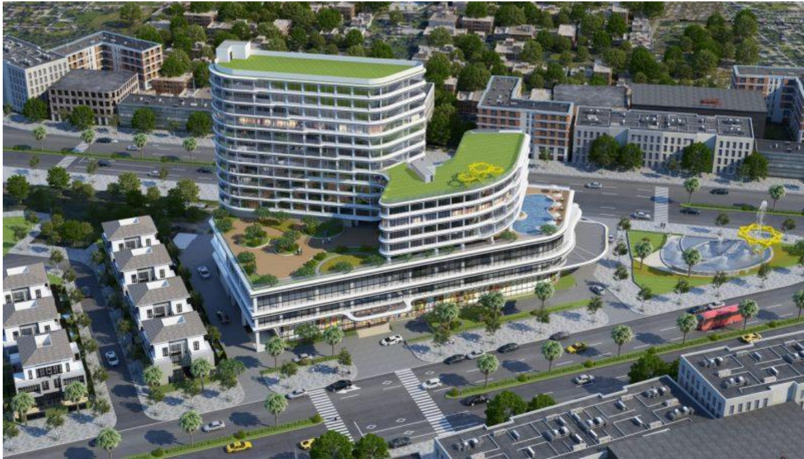
CÔNG TRÌNH/ CONSTRUCTION: THẨM TRA MÓNG CẦU THÁP, BIỆN PHÁP THI CÔNG TẦNG HẦM, BIỆN PHÁP THI CÔNG DẦM SÀN, GIÀN GIAO BAO CHE CHO DỰ ÁN TRUNG TÂM THƯƠNG MẠI DỊCH VỤ ĐÔNG SÀI GÒN, XÂY DỰNG TẠI LÔ T3-1.1 KHU CÔNG NGHỆ CAO, ĐƯỜNG LÃ XUÂN OAI, P.TẶNG NHƠN PHÚ - QUẬN 9 - TP, HỒ CHÍ MINH
